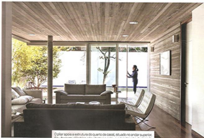
O pilar apoia a estrutura do quarto de casal, situado no andar superior. Seu formato cilíndrico não obstrui a sala, e a localização deslocada do canto permite a abertura total do vão, como mostra a foto acima.
